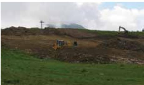
Foto 7.11. In terreni ricchi di pietre, per l'asporto dello strato superficiale di suolo sono più adatti scavatori e pale caricanti (G. Della Giacoma).
