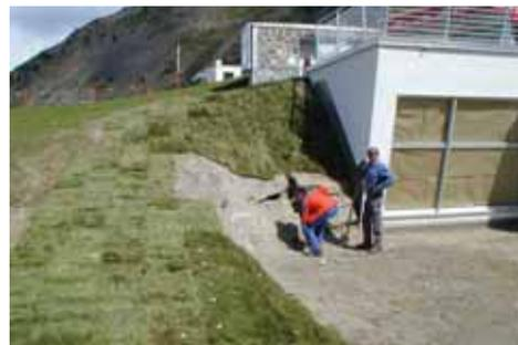
Foto 10.32. Restauro con zolle in rotoli di graminacee alpine ad un’altitudine di 2400 m s.l.m. Dopo la posa, il rotolo si insedia senza particolari interventi colturali e offre un’immediata protezione contro l’erosione (C. Tamegger).
