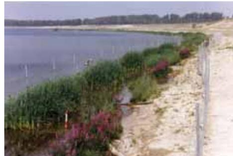
Foto 10.28. Protezione spondale con materassi di vegetazione e piantagione nella cava di Großkayna poco dopo il raggiungimento del livello finale della falda acquifera (A. Grüttner).
