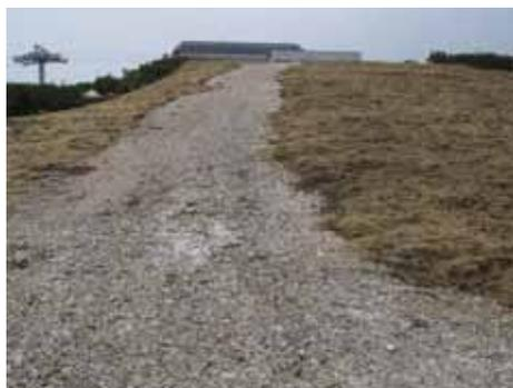
Foto 10.20. Applicazione di pacciamatura di fieno su una pista da sci (B. Krautzer).
