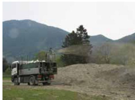
Foto 10.12. Idrosemina per il restauro dell'argine di un fiume (A. Blaschka).
