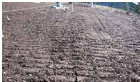
Foto 9.3. La creazione di solchi trasversali lungo le linee di livello migliora il successo del restauro (B. Krautzer).
