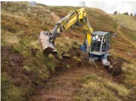
Foto 10.30. Con un’appropriata pianificazione temporale dell’intervento, le zolle erbose possono essere estratte e trapiantate in una stessa operazione (W. Graiss).
