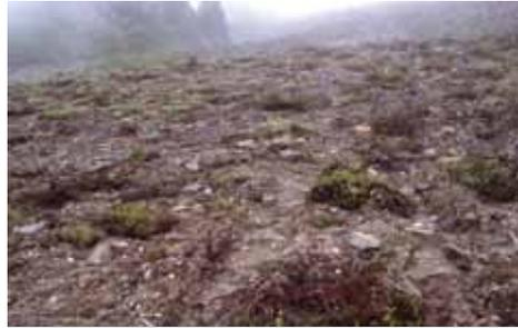
Foto 10.37. Le zolle rimosse nel corso dei lavori di costruzione sono state posate a griglia e il suolo nudo è stato seminato con un miscuglio di specie idonee (B. Krautzer).
