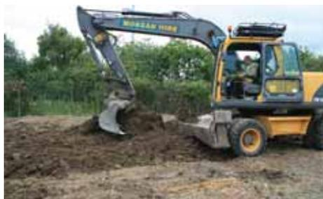
Foto 10.35. Spargimento di uno strato di 15-20 cm di suolo proveniente da una prateria ricca di specie in una discarica di inerti da edilizia in Ellesmere Port, Cheshire / Northwest England (P. Putwain).
