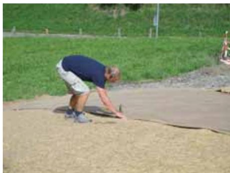
Foto 10.25. Una rete di juta viene distesa sopra una copertura di paglia per ottimizzare la protezione della semina (B. Krautzer).
