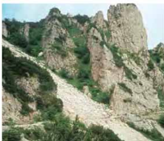
Sentiero Milani interrotto da una frana recente (G. De Franceschi)
