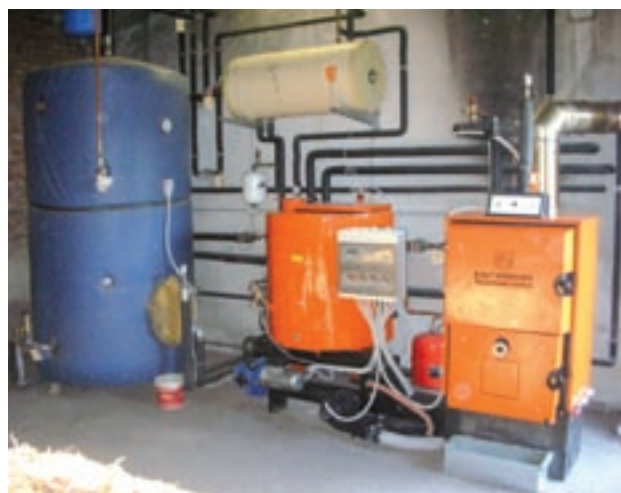
Figura 6.1: caldaia a cippato a griglia fissa.
