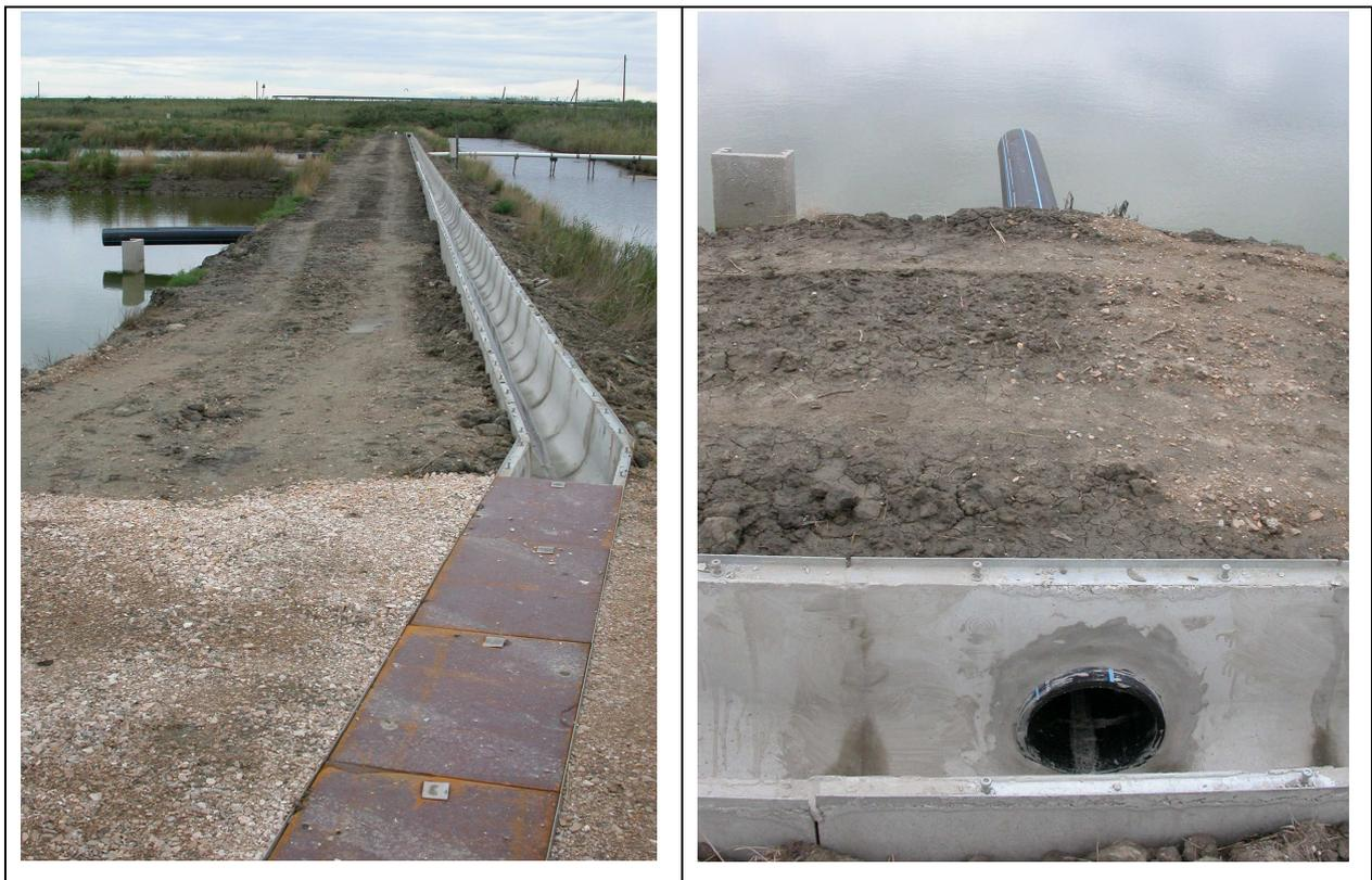
**Figura 2 – Canale di distribuzione dell'acqua in costruzione e dettaglio dello stacco di derivazione per l'immissione dell'acqua in una vasca**
