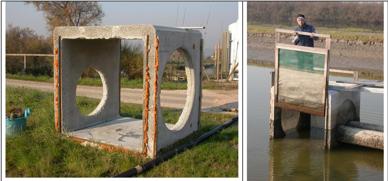
**Figura 3 – Pozzetto di scarico in preparazione per l'installazione delle griglie di filtrazione e le tubazioni di scarico (a sinistra) - Pozzetto posato in opera (a destra) con griglie per prevenire la fuga di gamberi dalla vasca di allevamento (passerelle e camminamenti provvisori)**
