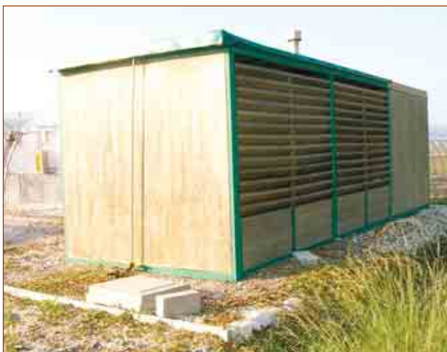
Foto 15. Silo di deposito del cippato
