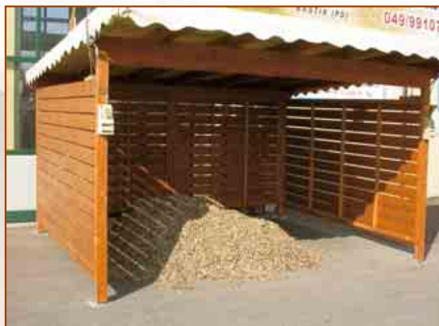
Foto 11. Stoccaggio del cippato sotto tettoie areate
