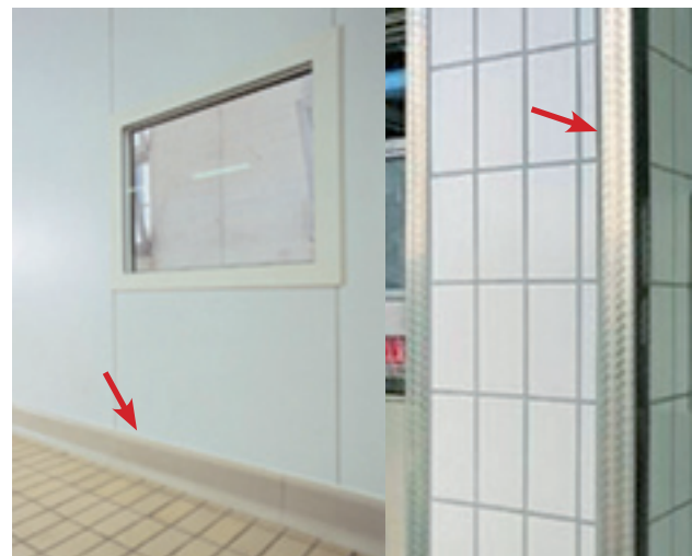
Figura 44. Esempi di protezione; zoccolino e parasigoli
