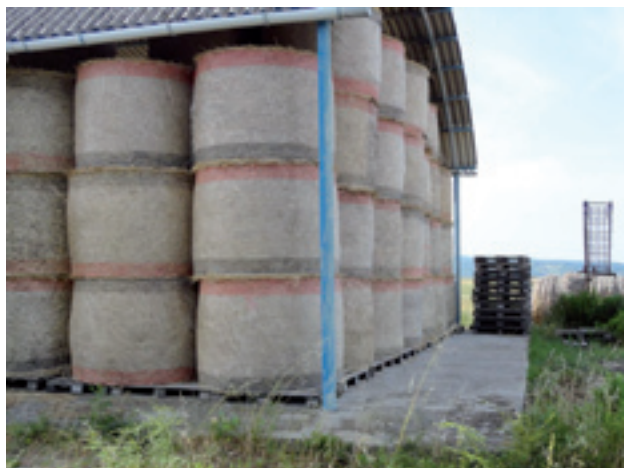
Figura 55. Deposito a tettoia
