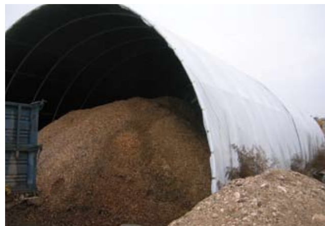
Il cippato secco (con contenuto idrico minore del 30-35%) deve essere conservato al coperto. L'apporto di acqua meteorica reinnescherebbe di fatto la fermentazione con progressiva perdita di sostanza secca, oltre al fatto che il cippato umido poi non sarebbe più utilizzabile nelle caldaie a griglia fissa
