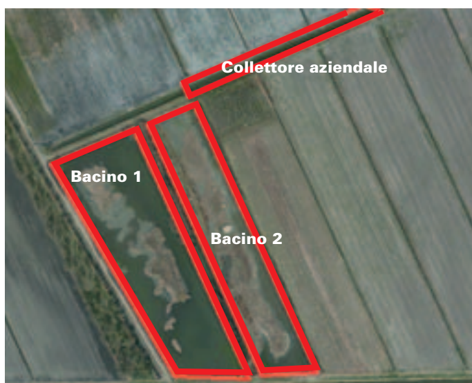
Figura 1 – I bacini e il canale prima della costruzione dell'impianto fitodepurante.
