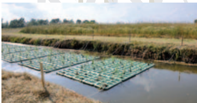
Figura 3 – Ancoraggio delle barriere di flottanti alla riva del canale collettore tramite funi.
