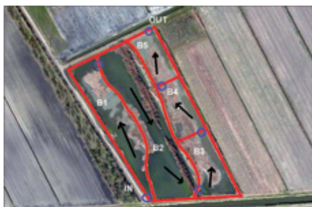
I bacini e il canale dopo della costruzione dell'impianto fitodepurante.
