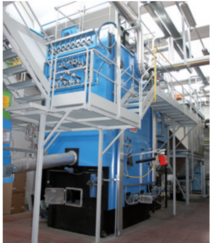
Figura 4 – Esempio di caldaia a cippato per il riscaldamento delle serre.
