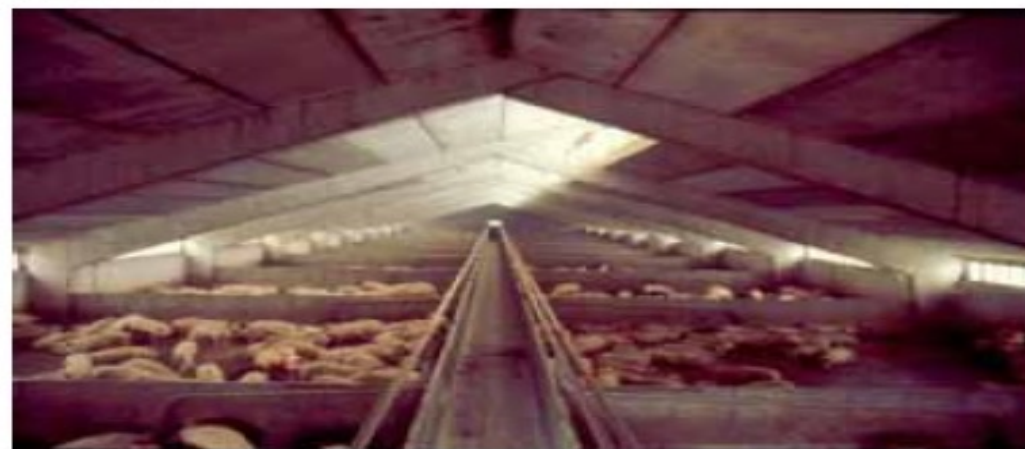
Figura 8 – Corridoio di servizio.
