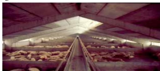
Figura 8 – Corridoio di servizio.
