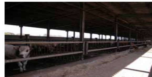
Figura 1 – Ricoveri per vitelloni da ingrasso con pavimento fessurato.
