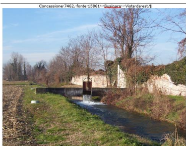
Concessione 7462, fonte 15861 - Businara - Vista dello scaricatore e dello scivolo. 1
