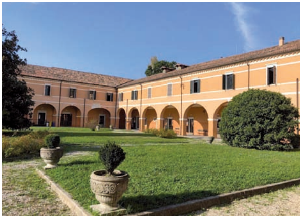
La sede dell'Istituto Tecnico Agrario.
